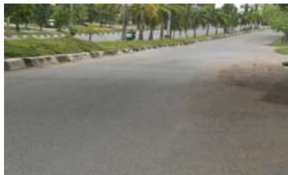
Gambar 2. Kondisi Eksisting Jalan
